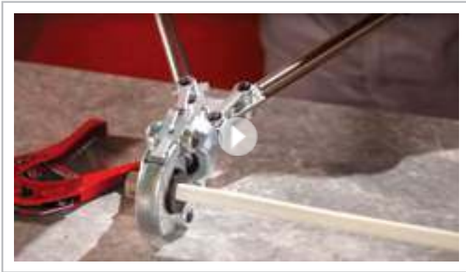
Монтаж металлопластиковых труб.
